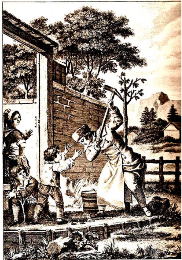
Un aqueduc! s'écrioit il en brisant tout, un aqueduc! un aqueduc!
